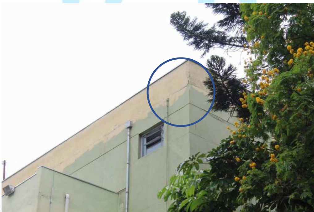
Figura 03 – Detalhe da platibanda com fissuras na fachada.
