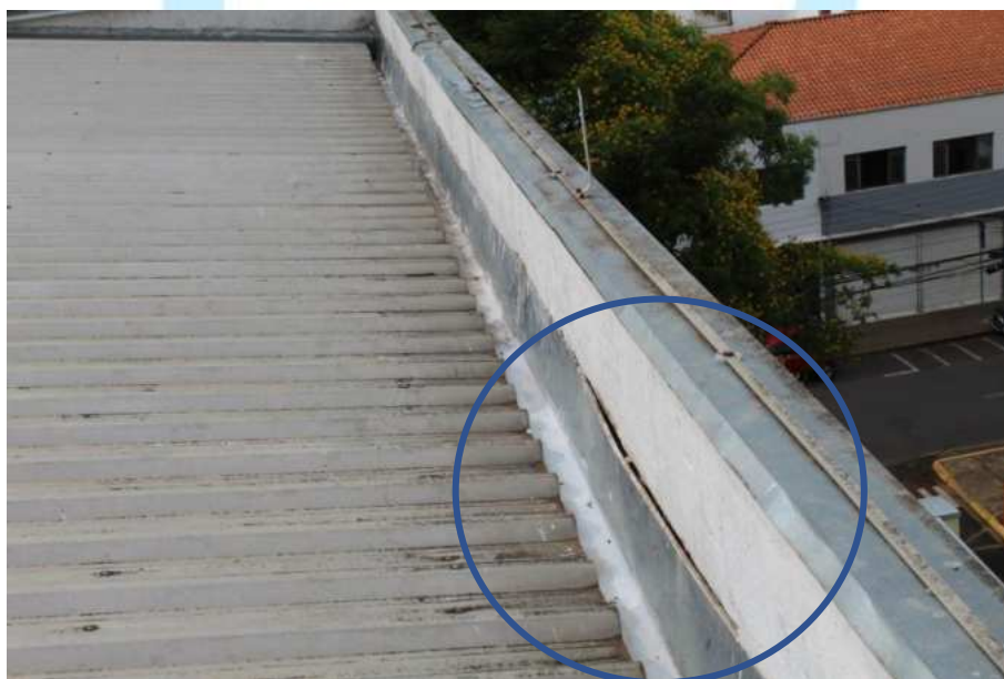
Figura 01 – Vista do telhado com falha na vedação dos rufos.
