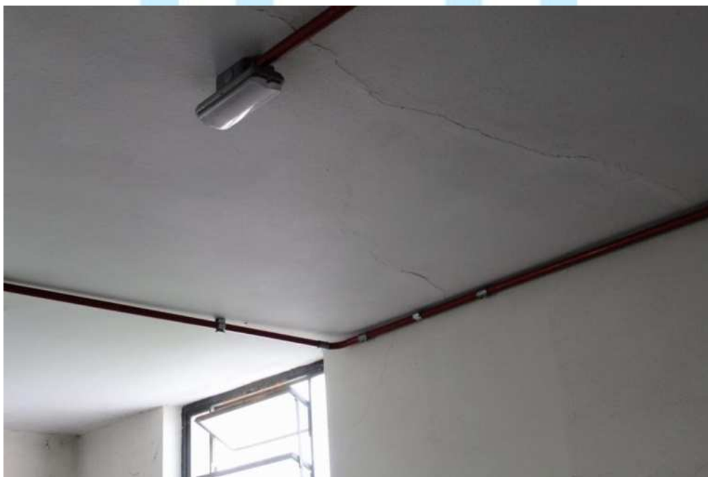
Figura 09 – Fissuras distribuídas pela laje próximas ao ponto com falha na vedação da cobertura.
