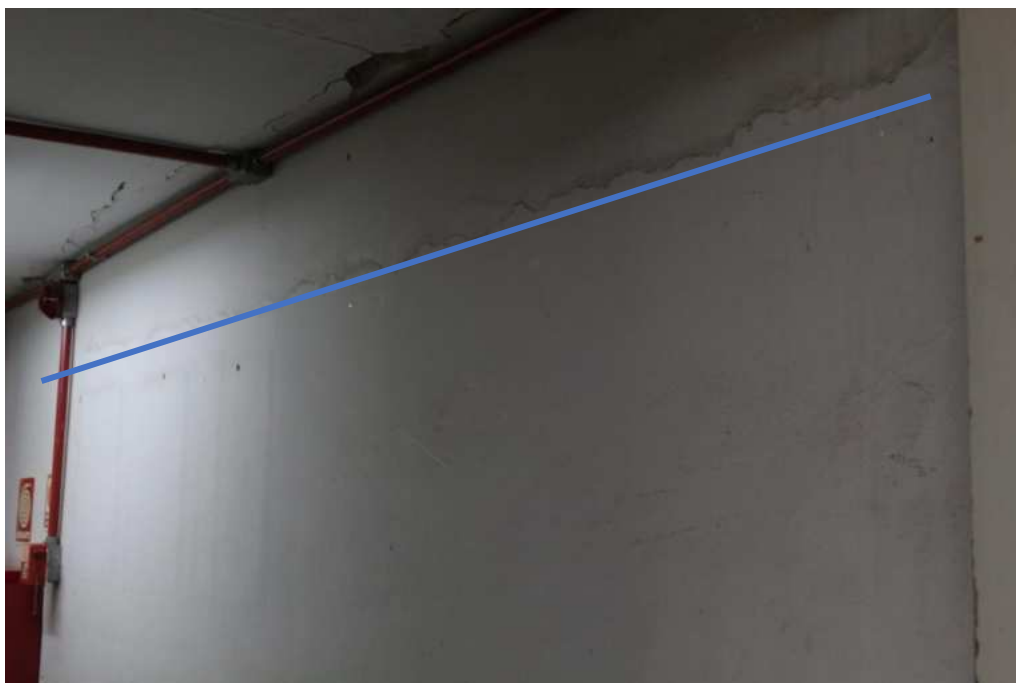
Figura 04 – Fissura/Trinca interna, abaixo da laje de cobertura, localizada no ponto de vazamento do rufo.
