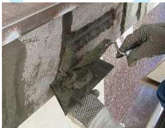
Figura 14 – Procedimento de reparos com argamassa polimérica.
