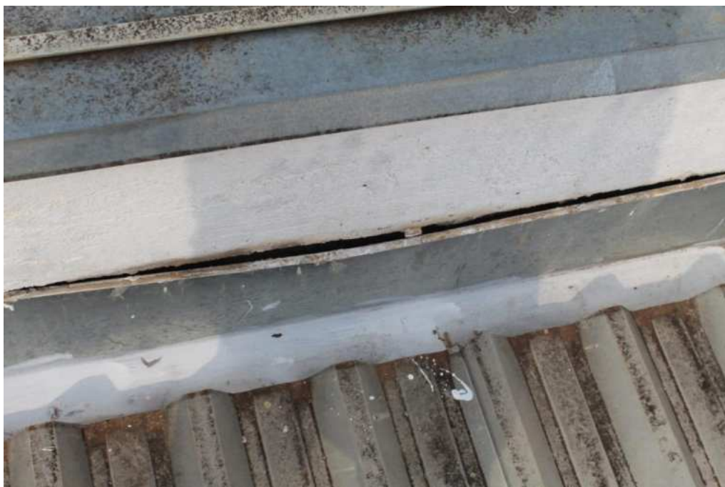
Figura 02 – Detalhe do rufo com falha na vedação.
