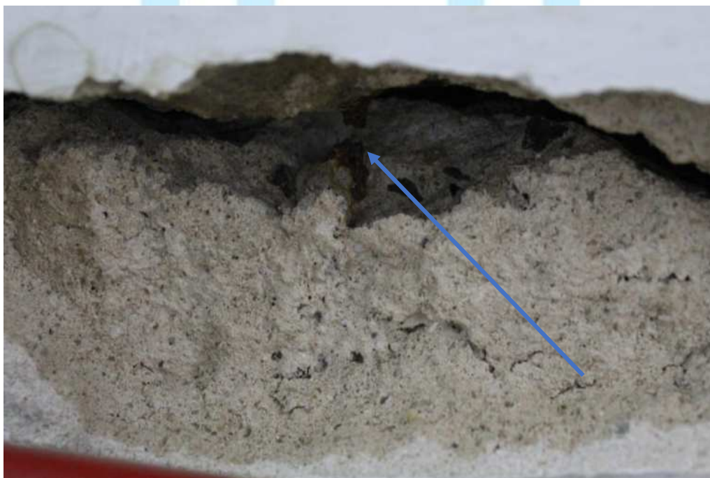
Figura 11 – Observa-se que a armadura da tela soldada está rompida, devido ao processo de corrosão.
