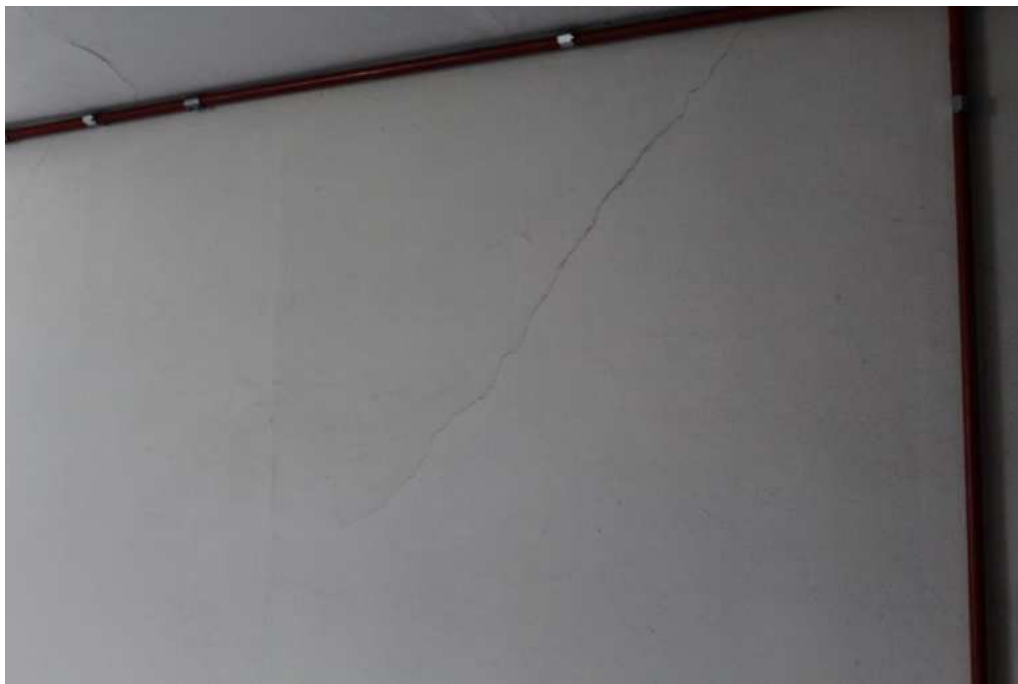
Figura 08 – Fissuras distribuídas pelas paredes próximas ao ponto com falha na vedação da cobertura.
