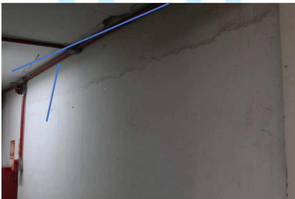
Figura 05 – Fissura/Trinca interna, abaixo da laje de cobertura, localizada no ponto de vazamento do rufo.
