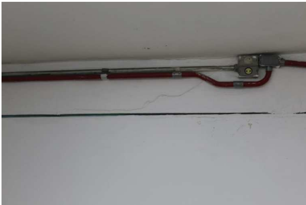
Figura 06 – Fissura diminui sua espessura conforme se afasta do local de infiltração.
