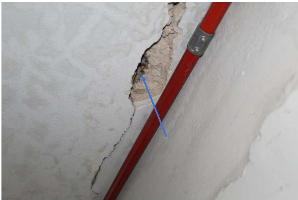
Figura 10 – Ponto mais crítico apresenta tons avermelhadas que significa processo de corrosão da armadura.
